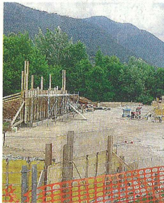
Cantiere. Lo stato dei lavori
